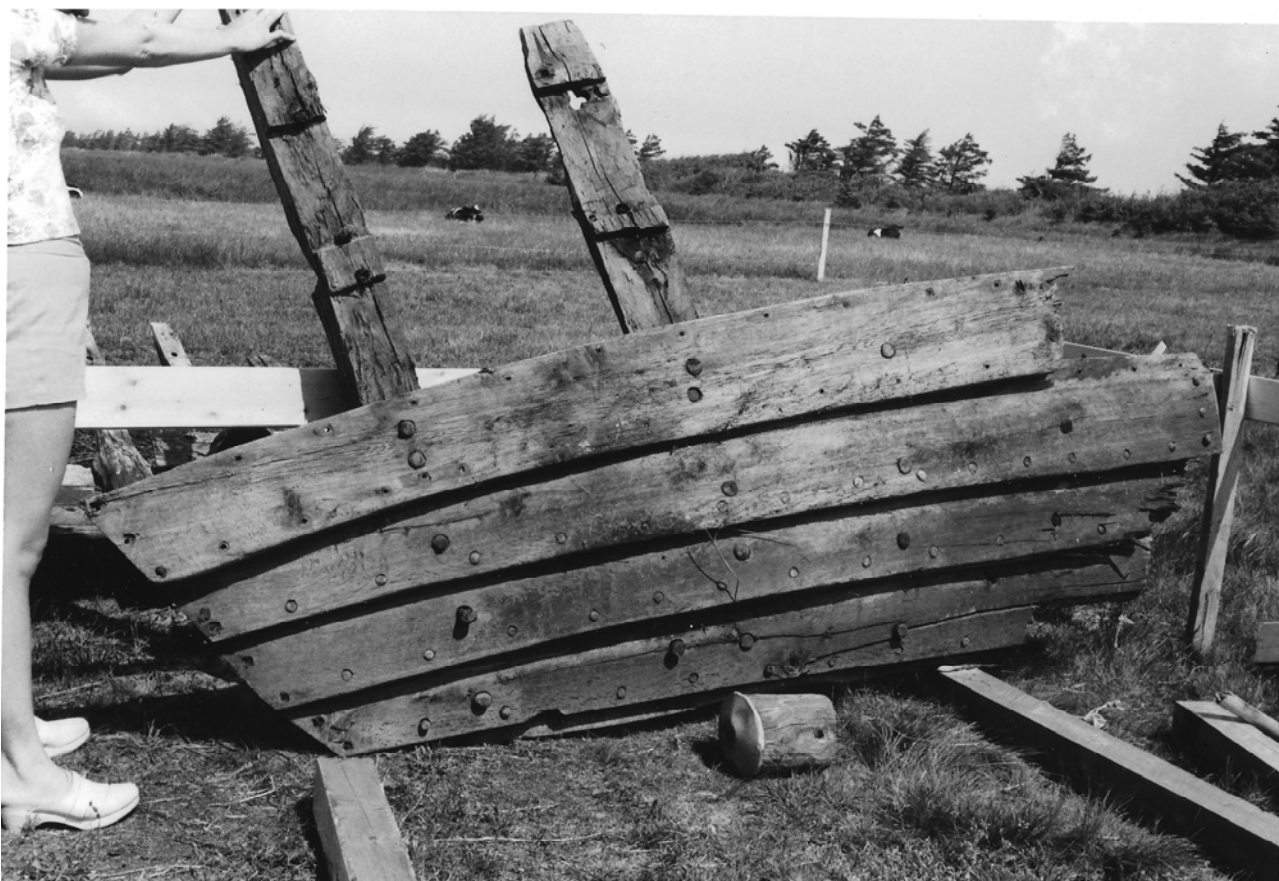
Vragdel 4 er rejst på højkant i juni 1976, så man ser skibssiden udefra, som den har taget sig ud med enebærnaglernes hoveder i konstruktiv orden.
