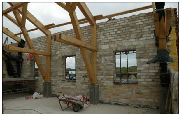
Vestfacaden set indefra. Over vinduerne er der også muret rulleskifte i limsten. Foto: Pipsen
