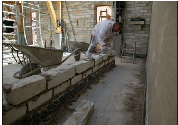
Muren mellem trappen og det store rum skal ses fra begge sider, så limstensene er savet til i bredden.
