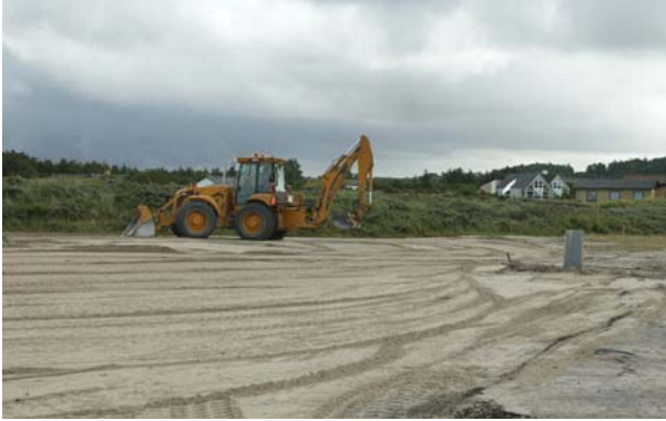
I midten af juli var nedrivning af gamle huse og klar- gøring af byggepladsen færdig. Foto: Pipsen
