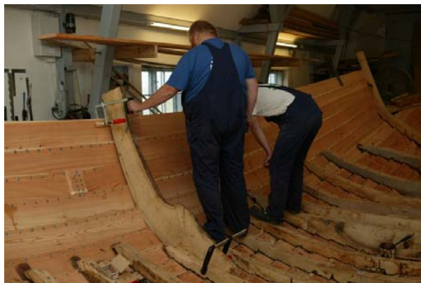
Freddy og Peter i gang med en af de første oplængere på Jammerbugt. Foto: Pipsen
