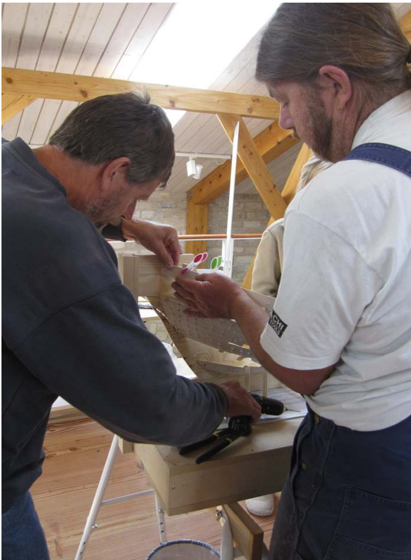
Mens der holdes, griber Morten boremaskinen for at bore nye huller til skruerne mere end en centimeter over de gamle huller.
