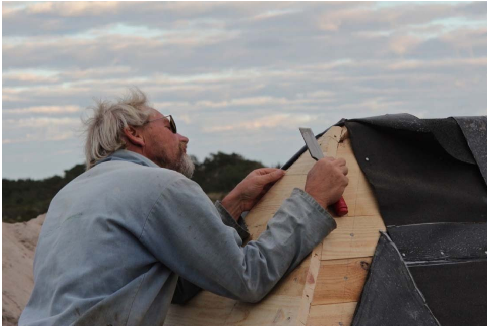
Et nyt undertag af simple brædder og god gammeldags tjærepap bærer det nye tørvetag.
