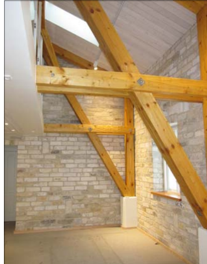
Detaljer af tømmerkonstruktionen i havbådehusets store rum med tømmer og limsten. Foto: Pipsen
