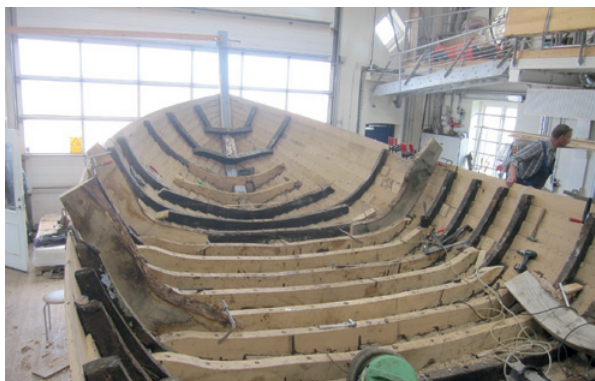
Midtskibs er alle bundstokkene skiftet, og nye oplængere er ved at blive lavet. Torben er ved at sætte det øverste bord fast i styrbord side. Foto: Pipsen
