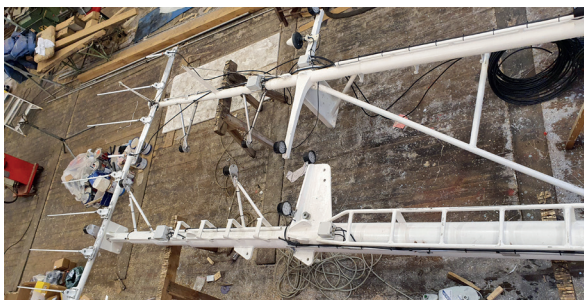
Masterne blev rigget til med lys og antenner inde i værftet. Foto: Pipsen
