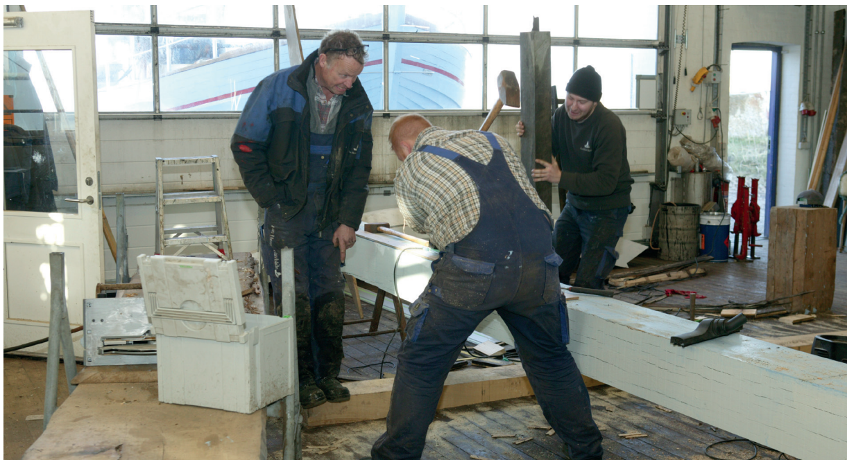
Gulvet i værftet skulle forstærkes, før der kunne bygges ny havbåd. Foto: Pipsen
