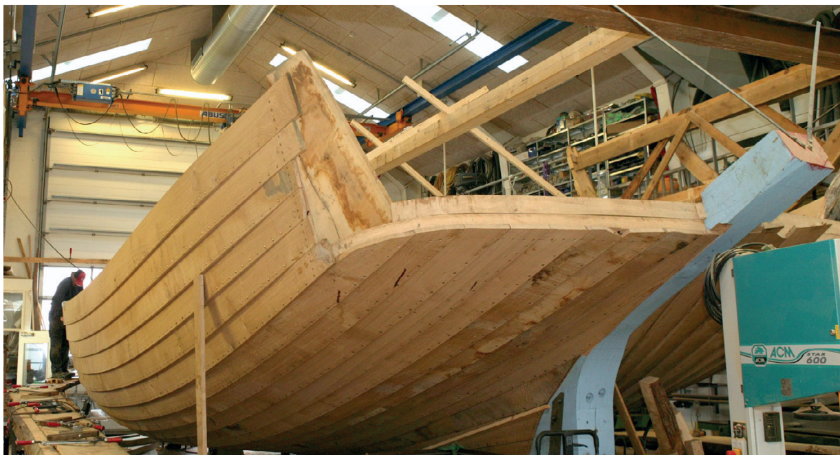
Tyvende og sidste bordgang på nybygningen er oppe. Foto: Pipsen
