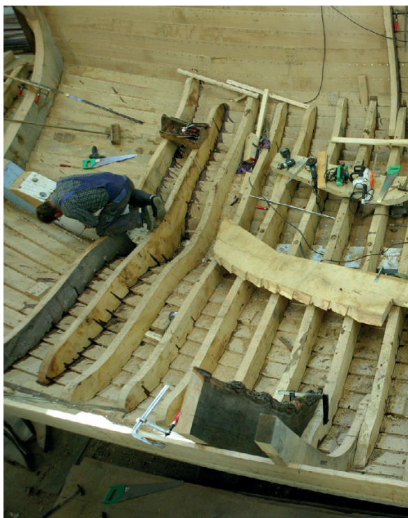
Torben er ved at gøre klar til de sidste bundstokke.
