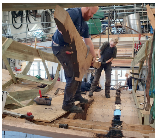
Anika og Andreas er ved at sætte en bundstok ned i skroget. Der er tjæret, der hvor bundstokken skal sidde. Foto: Pipsen
